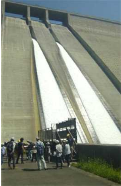
ダム下流広場の状況
